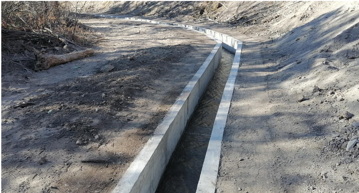
Figura N°25: Fotografía de proyecto de revestimiento de hormigón.
