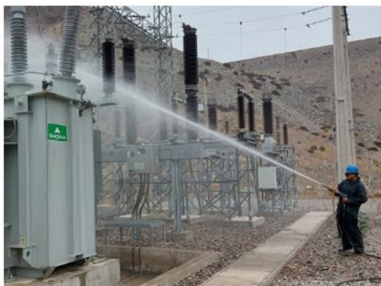
Figura N°15: Lavado de aisladores SSEE-RH y verificación de exactitud del medidor.
