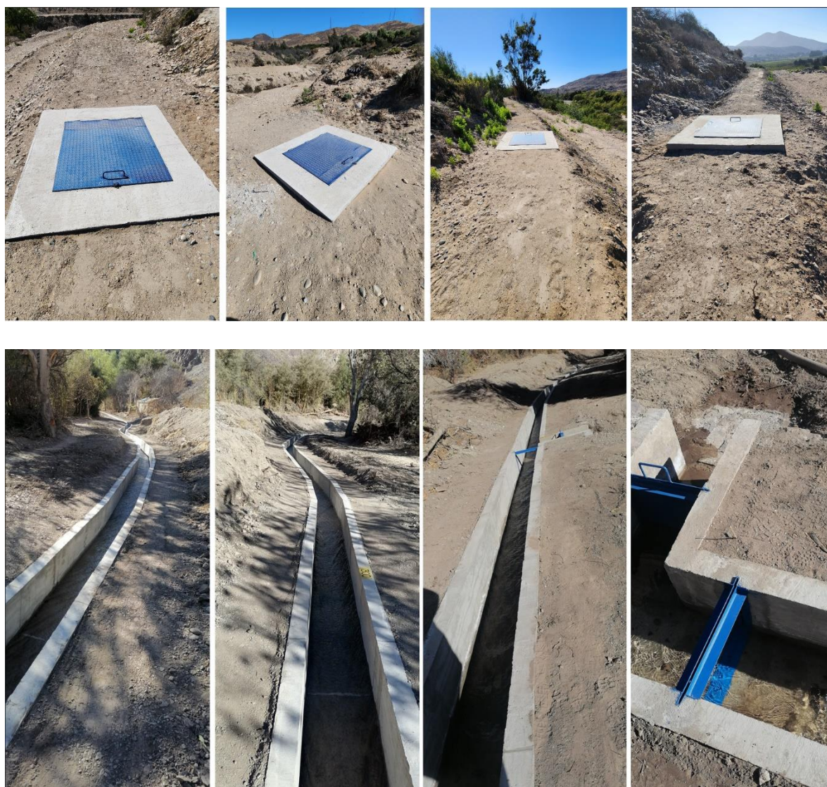
Figura N°28: Proyectos revestimiento de canales, periodo 2023-2024.
