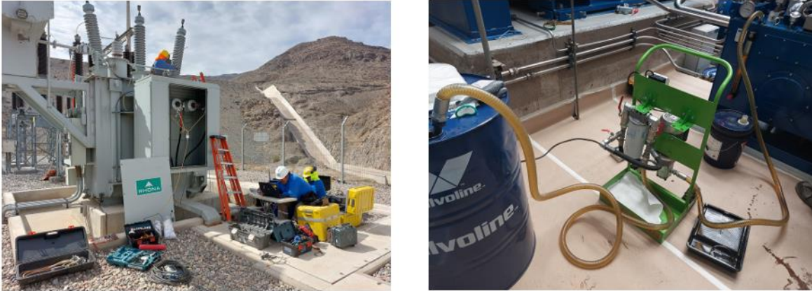
Figura N°16: Pruebas eléctricas a transformador y Micro filtrado de aceite.
