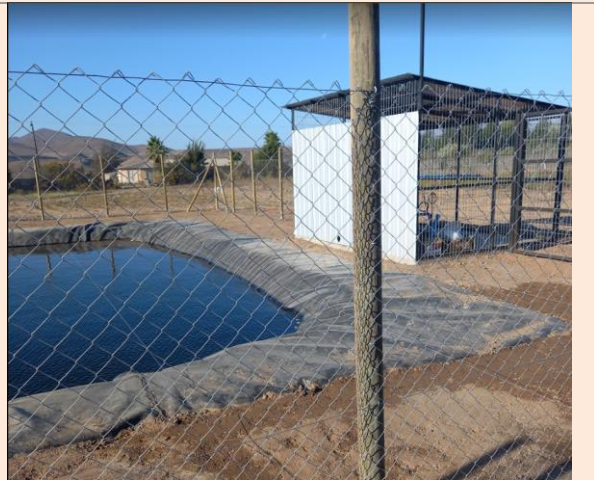
Caseta de riego y cierre de embalse-sector llanos de ferrera
