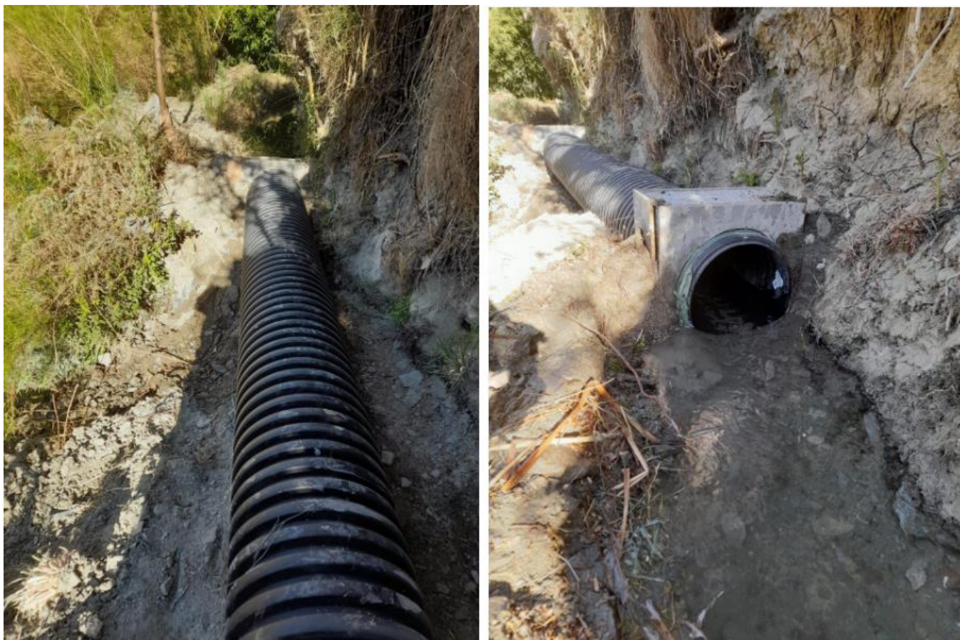
Figura N°30: Proyectos directos Fondo Pro-Agua Obras de Emergencia.
