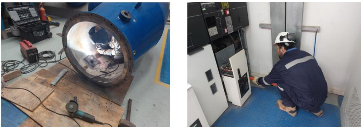
Figura N°17: Reparación de Codo Difusor U1 e Inspección de Celdas de Protección.
